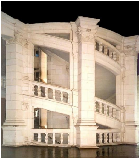
Der zentrale doppelläufige Wendelstein des Corps de Logis
